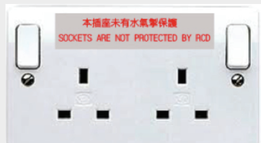
圖 6 無 RCD 保護的插座要有警告標誌
