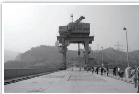
水霸上的大吊機
