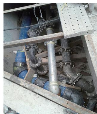
喉管安放在地下坑槽，可避免泥土流失而折斷
