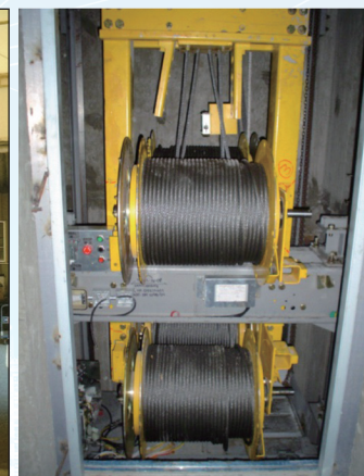
機廂纜和保險纜未用部分安放於機廂頂的兩纜轆內
