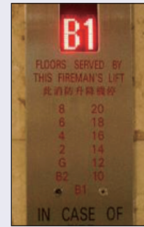
消防升降機服務樓層
