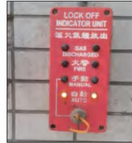
圖片為在高壓範圍完成工程或檢查後，及所有人員已離開，而通道門亦已關閉及鎖上，便將氣體撲滅系統轉回「自動」狀態的例子
