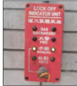
圖片為在高壓範圍進行檢查或工程時，須用鎖匙將滅火系統調校至「手動」狀態的例子
