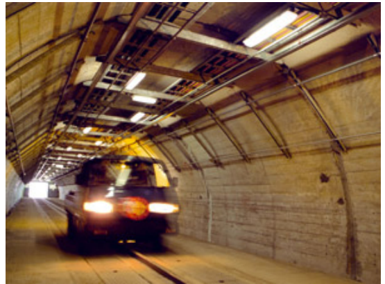
（圖片鳴謝：港燈）港燈的地底電纜隧道
