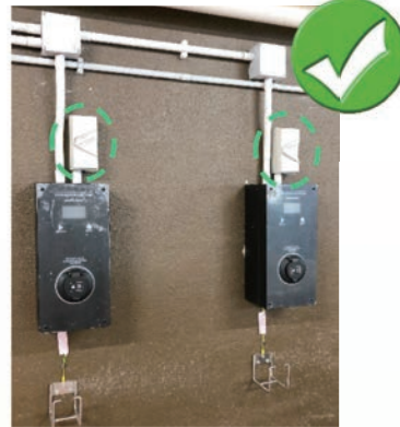
充電設施插座的上游位置應安裝斷流器（開關掣），以便在插上充電連接器後開啟電源，以及在拔出充電連接器前關上電源。
