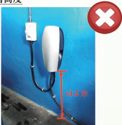
電動車輛供電設備或插座一般不應安裝在距離竣工地台水平 1.2 米高以下的位置。
