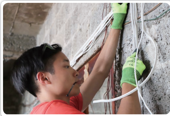
2019年廣西中停村無止橋建橋項目，學生義工在持電工牌照的導師帶領下，為有需要的村戶更換電綫。
