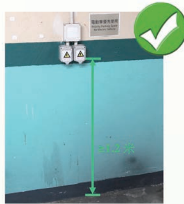
電動車輛供電設備或插座一般應安裝在距離竣工地台水平約 1.2 米高的位置，以便易於接觸。
