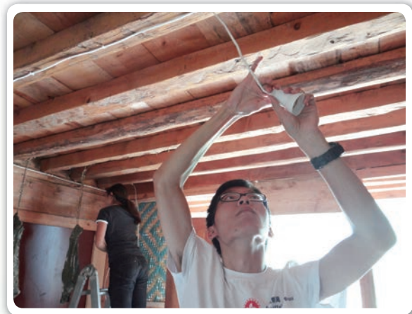
2018年雲南黎光村吾吉后無止橋建橋項目，學生義工為有需要的村戶更換室內電燈。
