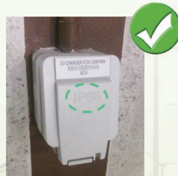
供室內停車場使用的電動車輛供電設備和插座及相關電力器具，均須加以適當防護以防止塵埃和水進入，有關的防護程度應達至 IPX3。在室外安裝及使用的電動車輛充電設施，則無論是在插頭已插上或並無插上的情況下，防護程度都應達至 IPX4 或以上。
