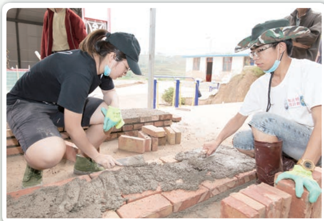
2018年8月甘肅馬岔村無止橋項目的服務團中，學生義工應用所學到的砌磚和水泥作業技巧，為村民砌築廣場上的座椅。
