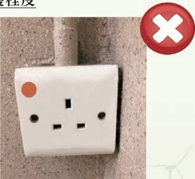
不可採用沒有適當防護的電動車輛供電設備和插座及相關電力器具。
