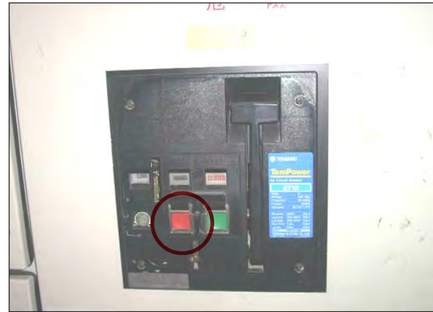
Photo 4 – Chiller #9 2500A ACB 圖 4 – 冷凍機 #9 2500A ACB
