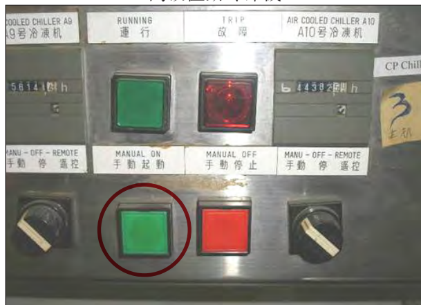
Photo 11 – For Chiller #10 圖 11 – 冷凍機 #10
