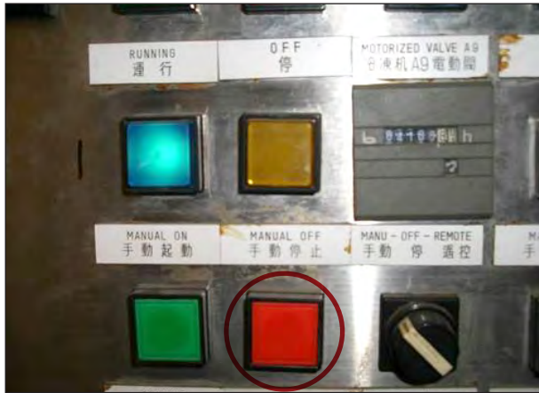
Photo 3 – For Chiller #9 Water Valve 圖 3 – 冷凍機 #9 水閘制
