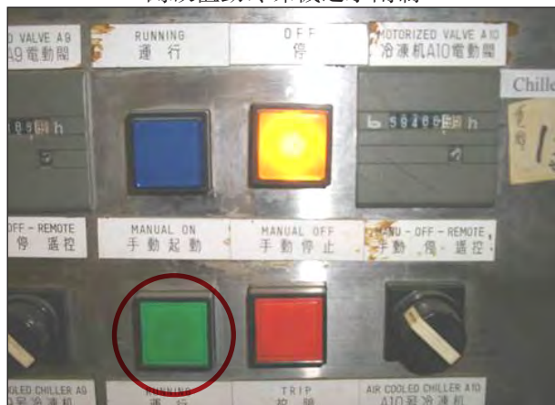
Photo 9 – For Chiller #10 Water Valve 圖 9 – 冷凍機 #10 水閘制
