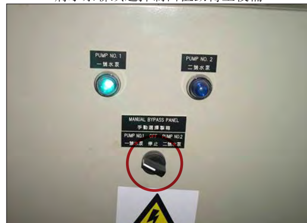
Photo 8 – For Water Pump Interlock Switch 圖 8 – 凍水泵聯鎖選擇制
