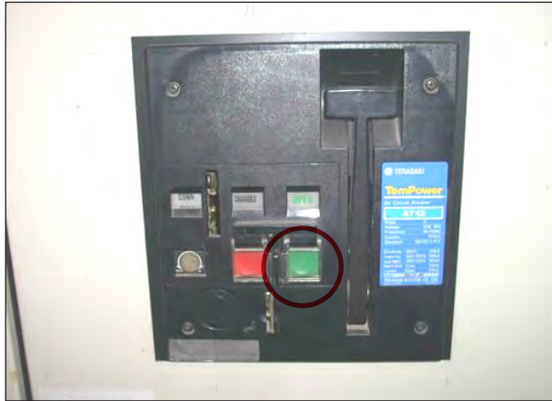
Photo 5 – Chiller #10 2500A ACB 圖 5 – 冷凍機 #10 2500A ACB
