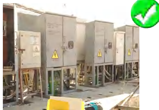
防風雨箱及客戶的低壓總開關箱的位置須安裝在建築工地周邊及面向行人路，防風雨箱正前方須提供不少於 900 毫米的工作空間。
