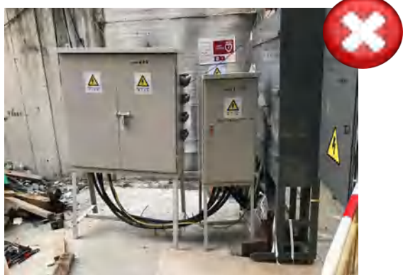
客戶的低壓總開關箱安裝在建築工地範圍內，及面向工地而非行人路。
