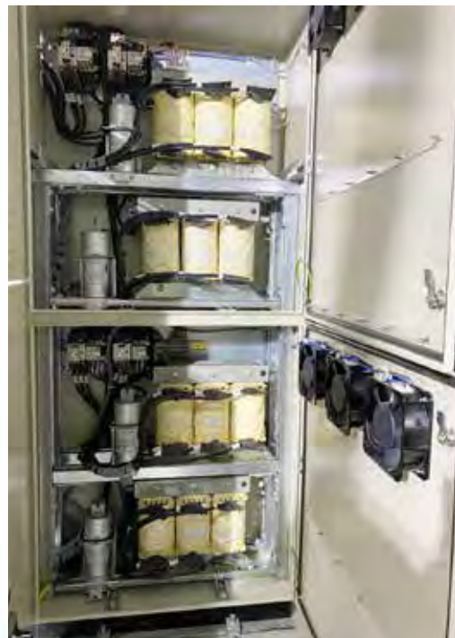
圖 9 · 諧波過濾裝置 (Filter) 的完成相片。
