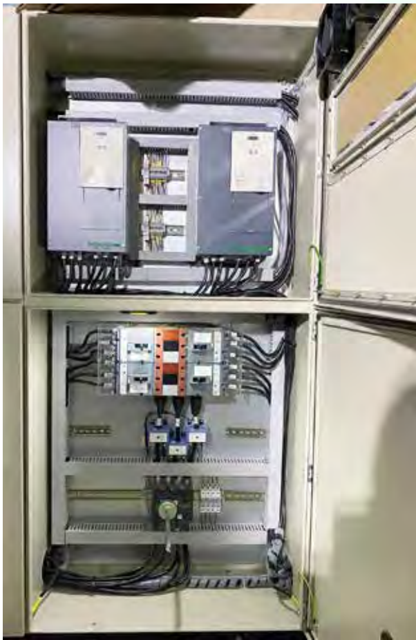
圖 10 VSD 和供、配電開關 (MCCB) 的完成相片。
