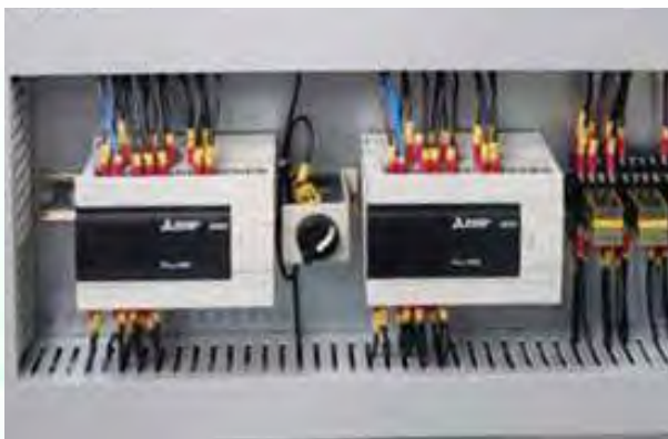
圖 12 兩部 PLC(1-On Duty, 1-Standby) 通過手動 選擇開關控制。
