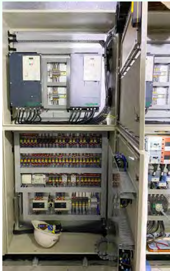
圖 11 VSD 和控制繼電器 (Relay) 的完成相片。
