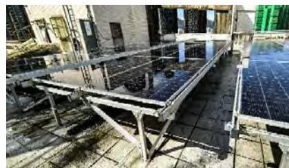
圖二，以轉孔於地台用螺栓固定在天台上。
